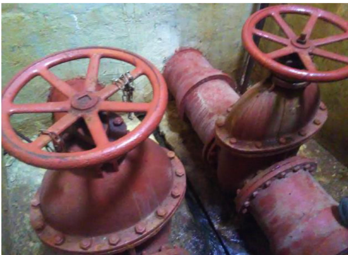
Obr.8 - detailní pohled na dvě regulační šoupata DN 400
