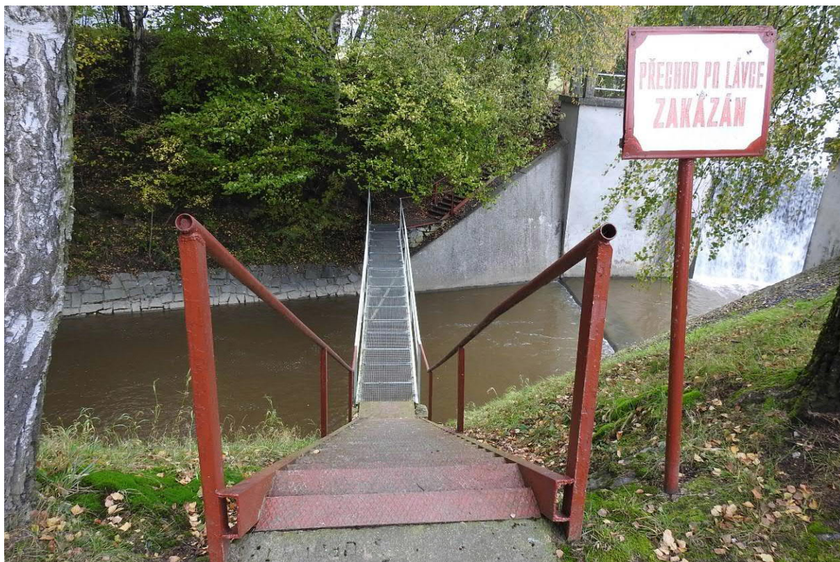
Obr.9 - pohled na ocelovou lávku na vývarem s navazujícími ocelovými schodišti
