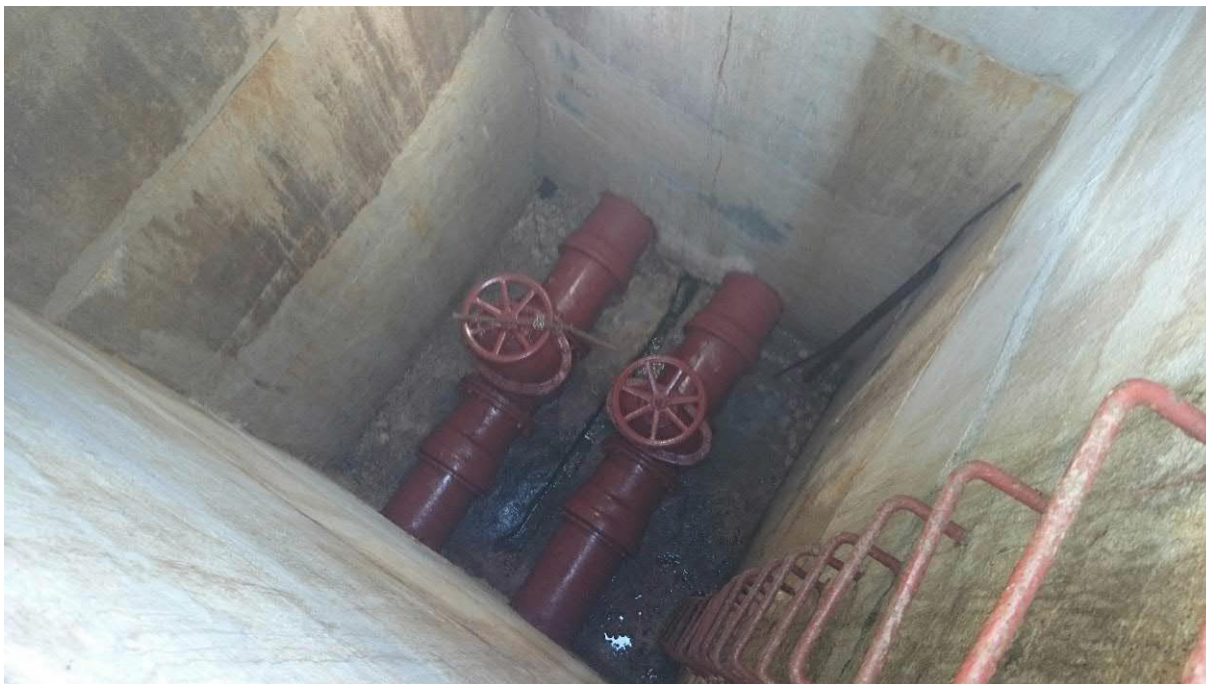
Obr.7 - pohled do šachty uzávěrů spodní výpusti s dvěma regulačními šoupaty DN 400
