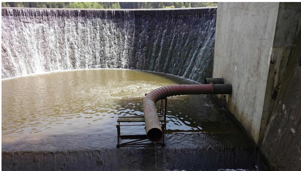
Obr.6 - pohled na vývar s vyústěním spodních výpustí
