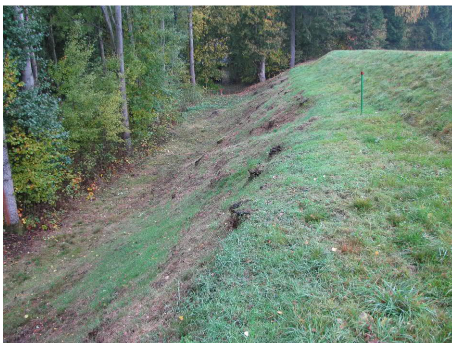
Obr.2 - pohled na vzdušný líc s přítěžovací lavicí
