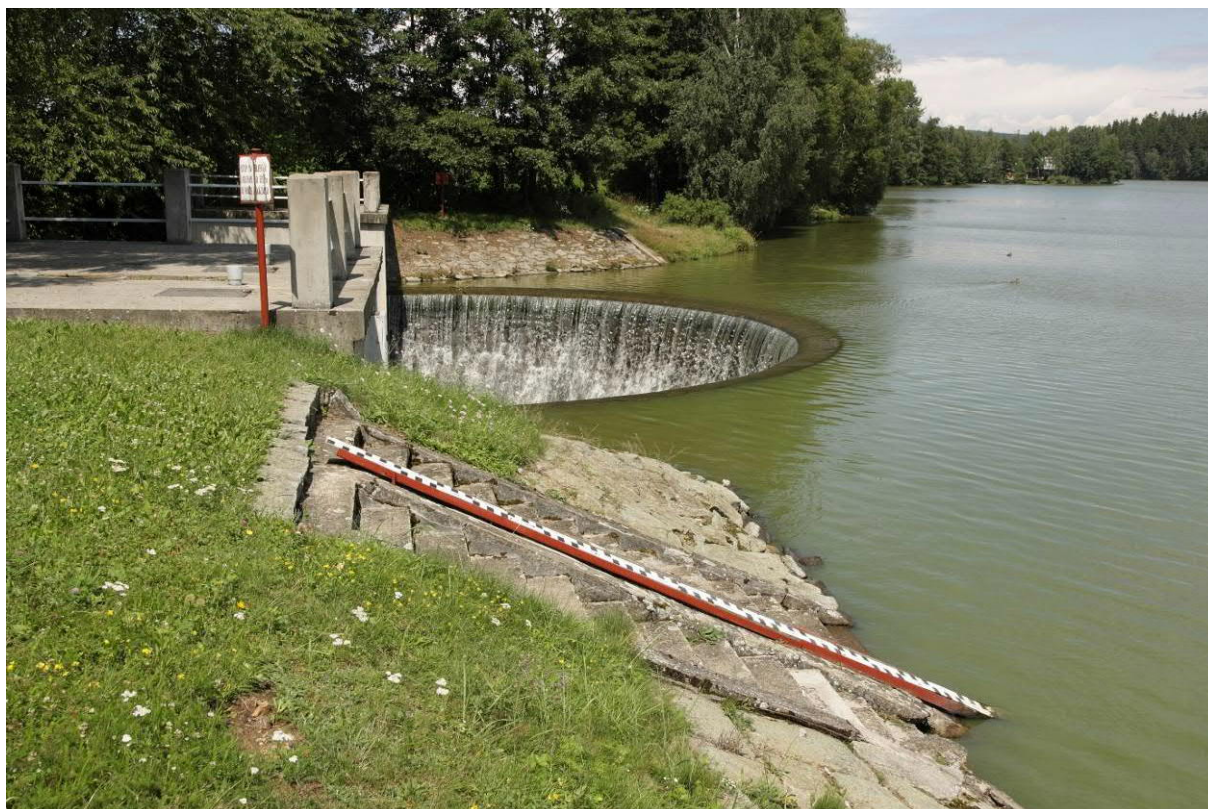
Obr.5 - pohled na bezpečnostní přeliv VD Strž
